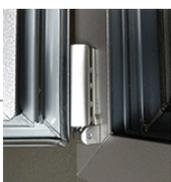
Der Dreh- und Angelpunkt ist das Ecklager. Auf ihm sitzt quasi das gesamte Gewicht des Flügels. Wird das Fenster geöffnet bzw. gekippt, bleibt der Flügel
