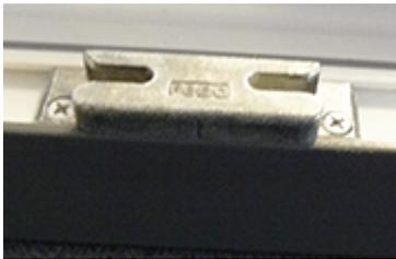
Schließbleche sind das Gegenstück zu den Verriegelungszapfen. Sie sind in den Rahmen eingelassen und eines der neuralgischen Bauteile was den Einbruchschutz betrifft. Oft setzen hier Einbrecher mit Schraubendreher oder mit einem Nageleisen an um das Fenster aufzuhebeln.
