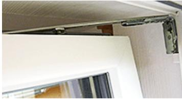
Eines der wichtigsten Bauteile eines jeden Fensterbeschlages. Mit ihr lässt sich das Fenster kippen. Es ist sinnvoll dieses Bauteil ab und an zu ölen, damit eine jahrelange Gängigkeit gewährleistet werden kann.
