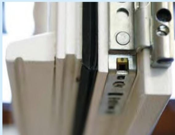
Die RAL-Gütesicherung überwacht konstruktive Details wie das fachgerechte Anbringen von Dichtungen und Beschlägen.
